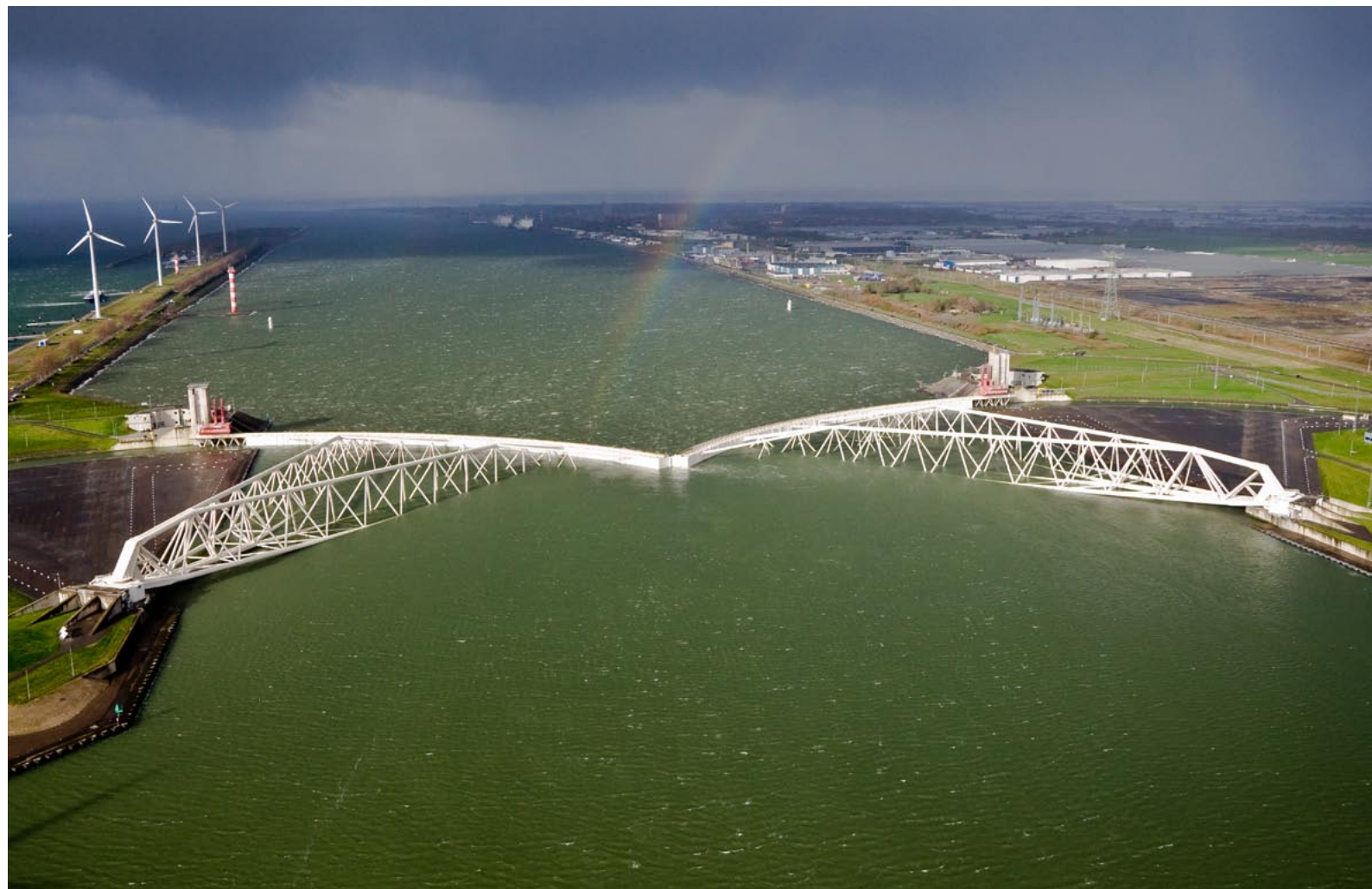
De Maeslantkering in Hoek van Holland
